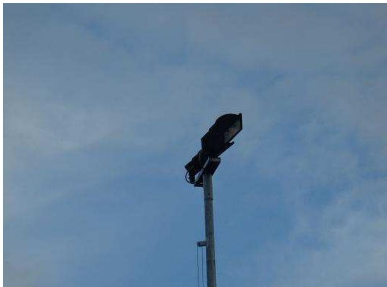
Armatura stradale conforme ma orientata non correttamente; il faro è da ruotare parallelamente al terreno.
