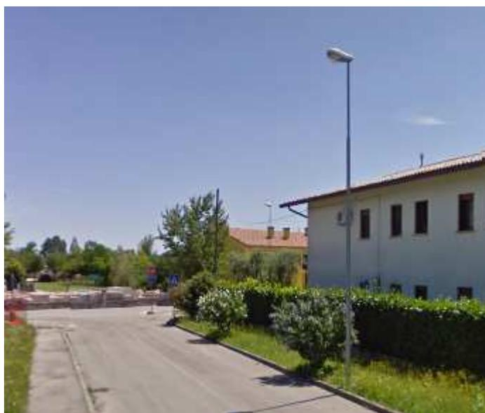
Linea interrata con pali in metallo dotati di lampade lampade Hg da 125 watt in apparecchio disperdente oltre la linea orizzontale. Si prescrive la sostituzione delle armature obsolete e delle sorgenti a mercurio con altre conformi alla L.R. 17/09 ed con orientamento parallelo al suolo. La linea risulta avere una interdistanza tra pali non inferiore a quanto prescritto dalla L.R. 17/09.
