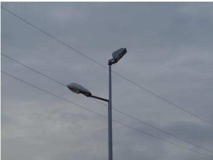
APPARECCHIO DA VALUTARE PUNTUALMENTE: corpi illuminanti che sono a norma solo in determinate posizioni di installazione che però non sono univocamente individuabili (esempio: il proiettore in funzione del suo puntamento e dei dispositivi di contenimento del flusso utilizzati, o l'incasso in funzione della posizione in cui è installato)
